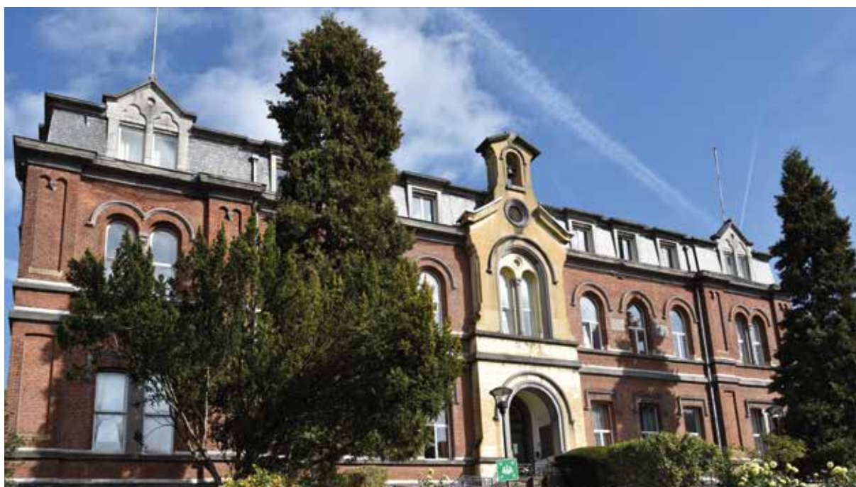
L'ancien home Van Aa, qui est occupé actuellement par des étudiants, va bientôt abriter les services sociaux puis être transformé en logements/ Het voormalige home van Aa, momenteel in gebruik door studenten, zal binnenkort de sociale diensten huisvesten en vervolgens omgevormd worden voor huisvesting.
